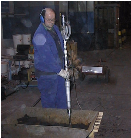
Abbildung 2: Druckluftstamper beim Verfestigen von Ofenausmauerungen
