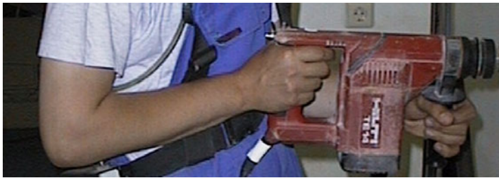
Abbildung 3: Typischer Einsatz eines Bohrhammers
