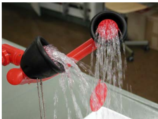
Abbildung 2-22: Augennotdusche in Betrieb
