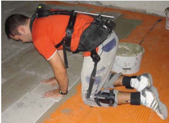
Abbildung 2-39: Belastungsmessung beim Verlegen von Bodenfliesen
