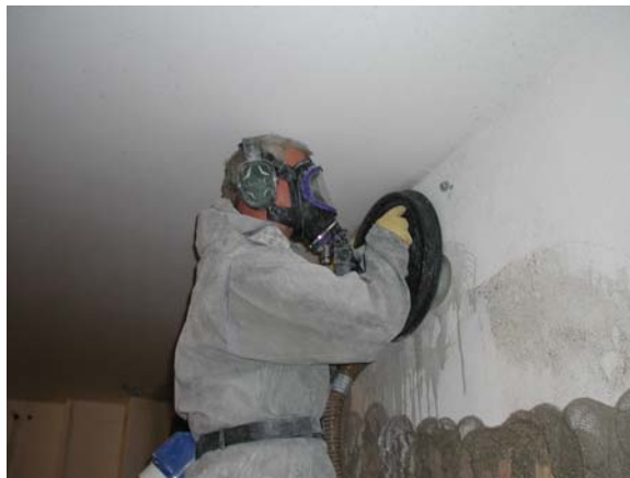
Abbildung 2-5: Belastung mit biologischen Arbeitsstoffen bei der Gebäudesanierung (Quelle: BGIA und BG BAU)
