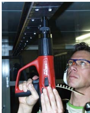
Abbildung 2-15: Setzen von Befestigungsbolzen
