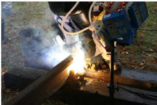
Abbildung 2-12: Schweißen von Schienenstößen
