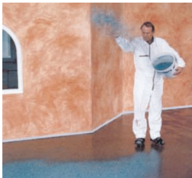
Bild 13 Vor Ort hergestellter Bodenbelag, Einstreuung von rutschhemmendem Quarzsand.
